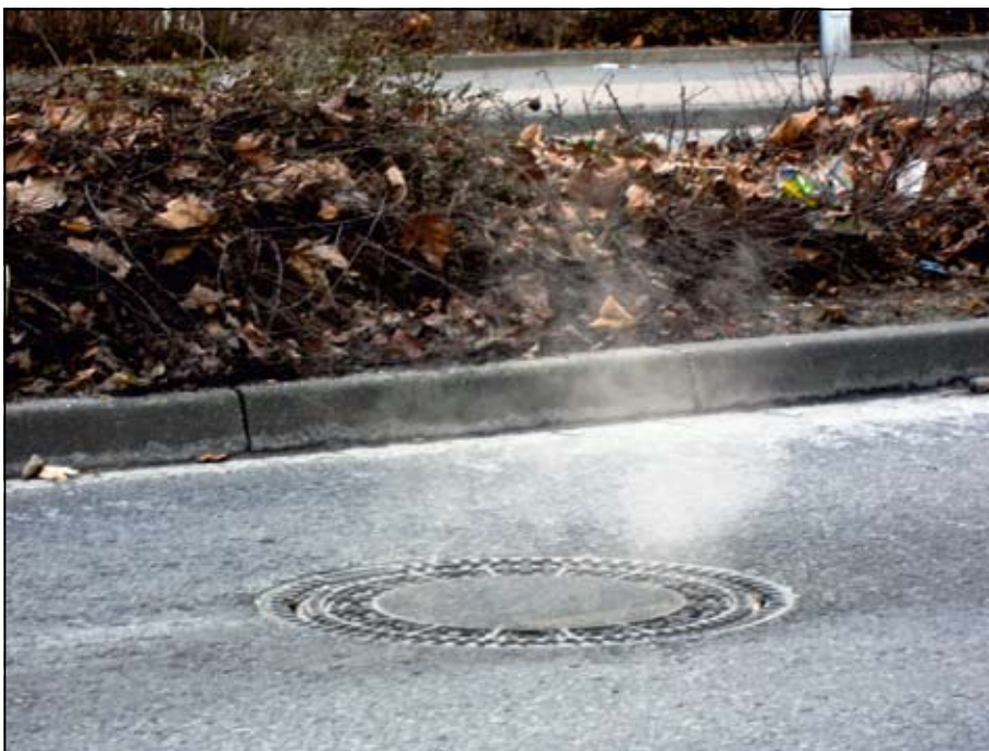
Dampfaustritt aus der Kanalisation
