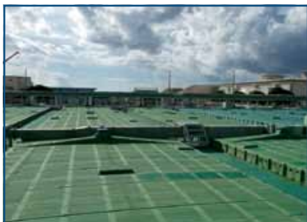
Abwasserreinigungsanlagen in Japan sind meist nah an der Wohnbebauung angelegt. In Ginuwan auf Okinawa herrschen ganzjährig hohe Temperaturen, sodass die Belebungsbecken abgedeckt sind.
