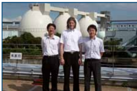
Große Teile der Abwasserreinigungsanlage von Kobe mußten nach dem schweren Erdbeben neu errichtet werden. Heute wird Biogas für den städtischen Fuhrpark und den öffentlichen Personennahverkehr genutzt. v.l.n.r.: Dr. Hashimoto, P. Staufer, Dr. Tsuji
