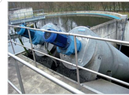
Belüftungsbecken mit umlaufender Belüftungsbrücke
