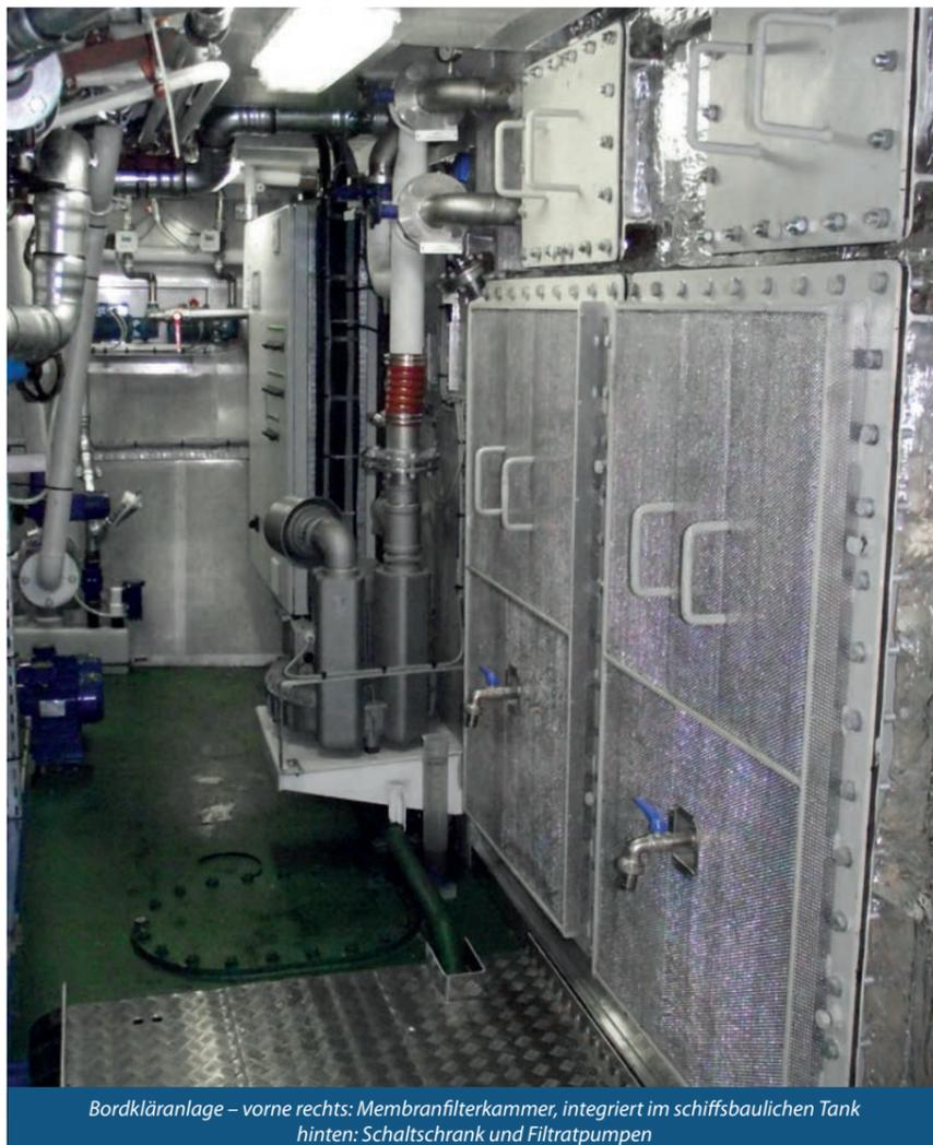
Bordkläranlage – vorne rechts: Membranfilterkammer, integriert im schiffsbaulichen Tank
