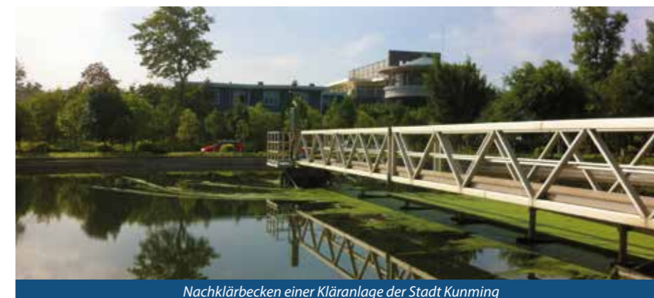
Nachklärbecken einer Kläranlage der Stadt Kunming
