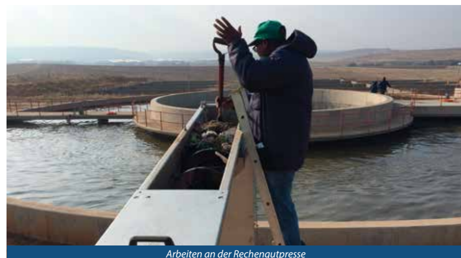
Arbeiten an der Rechengutpresse
