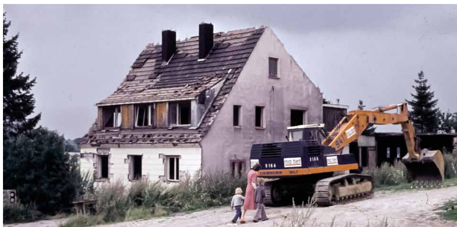
Das Wohnhaus Talweg kurz vor dem Abriss (1976)
