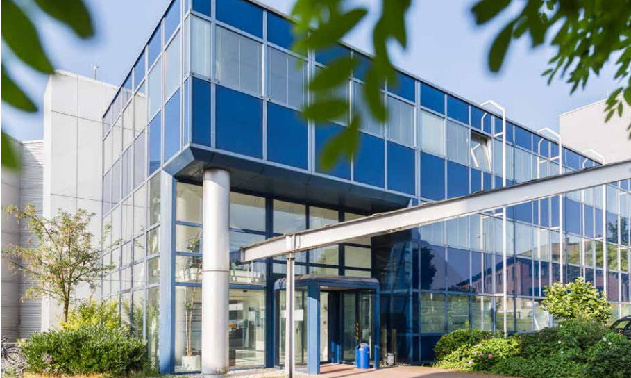
Seit über 5 Jahren arbeitet das FiW in dem modernisierten, technisch hervorragend ausgestatteten ehemaligen Aixtron-Gebäude an der Kackerstraße
